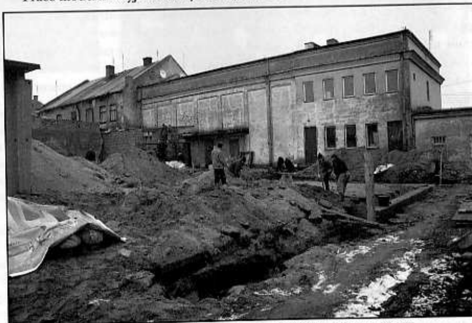
Roboty budowlane przy budowie nowego skrzydła budynku ChCK
