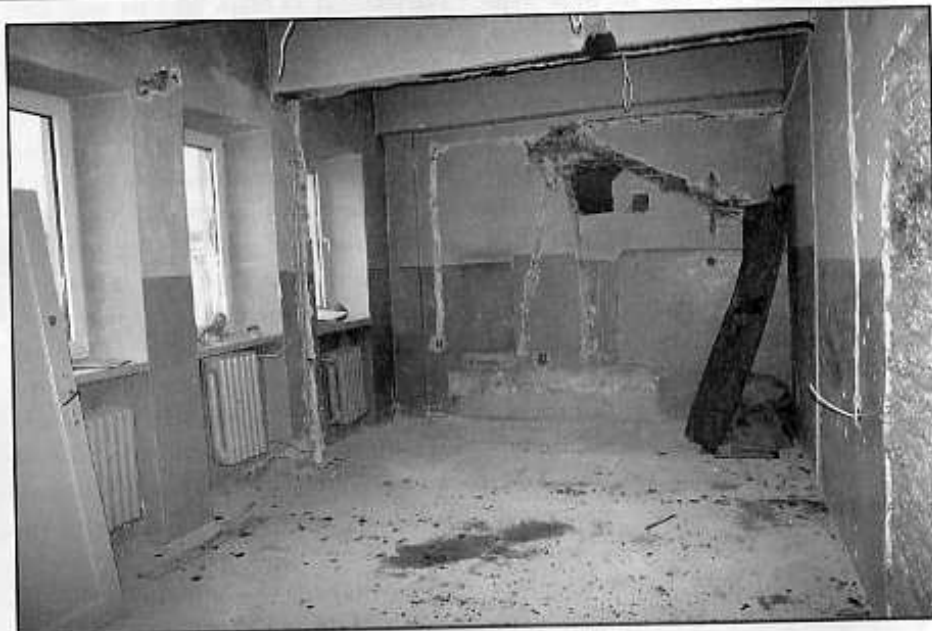
Prace modernizacyjne w starym budynku ChCK
